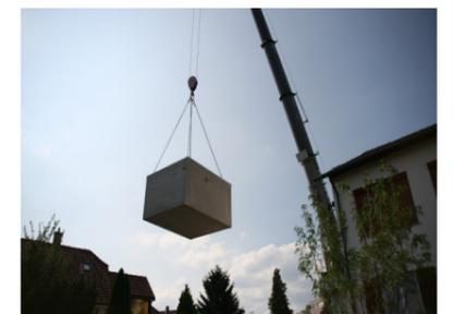
Garage wird mit einem Pneukran Versetzt
