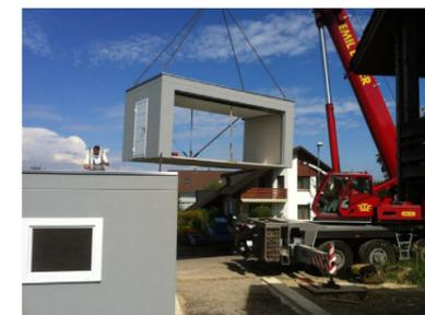
Garage wird für den Versatz mit einem Pneukran vorbereitet
